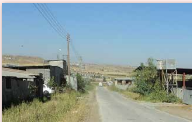
Παροχή ρεύματος στην Κτηνοτροφική Περιοχή Ξυλοφάγου
