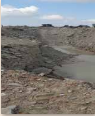
Λατομείο εξόρυξης πέτρας οικοδομής (κλιμάρα) στις Πάνω Κυβίδες στο στάδιο της τελικής αποκατάστασης, με στόχο τη διαφορετική χρήση γης και συγκεκριμένα τη γεωργική αξιοποίηση.
