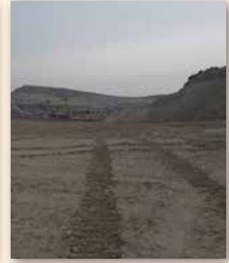
Λατομείο εξόρυξης σβεστικού ψαμμίτη για παραγωγή άμμου στο χωριό Κελλιά της επαρχίας Λάρνακας: (α) Αποκάλυψη λατομείου, και (β) Ταυτόχρονη προετοιμασία περιοχής όπου έχουν εξαντληθεί τα αποθέματα, για αποκατάσταση και χρήση στη γεωργία.
