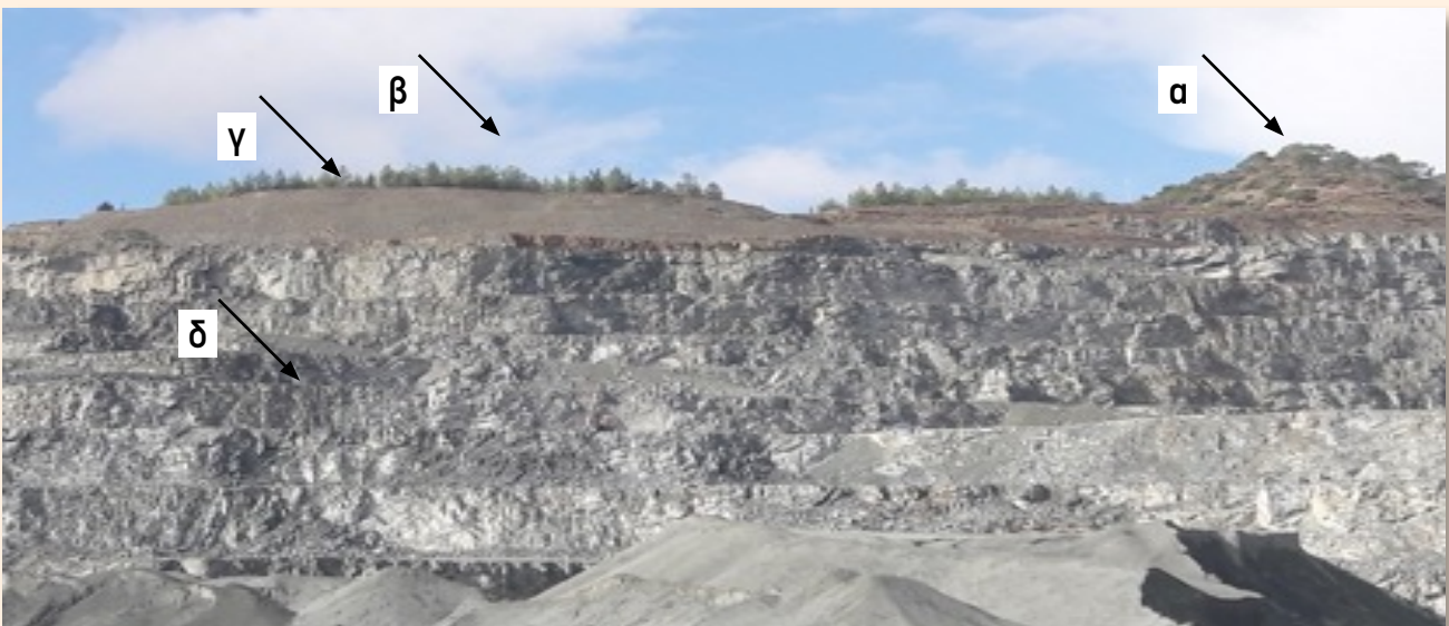
Πανοραμική εικόνα τμήματος της Λατομικής Ζώνης Παρεκκλησιάς (Νοέμβριος 2019). Διακρίνονται (α) το φυσικό δάσος, (β) η δενδροφύτευση του χώρου όπου είχαν εξαντληθεί τα αποθέματα, (γ) η προετοιμασία του εδάφους για φύτευση, και (δ) ο δραστήριος χώρος λατόμευσης.
